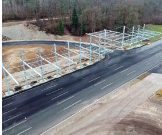
› Abb. 3 – Stahlgerüst der neu errichteten Outdoor Beregnungsanlage © DigiTrans GmbH
