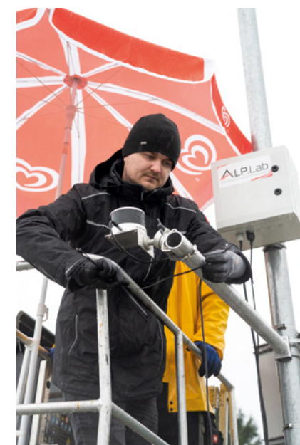
Abbildung 10: Verkabelung des Lidar-Sensors ©AustriaTech/Schallauer
